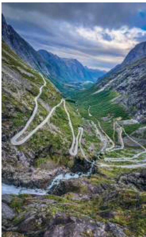
26. NÓRSKO: svetoznáma horská cesta Trollstigen a vodopád Stigfossen. Celá trasa bola vybudovaná ručne. Stavba cesty trvala 8 rokov práce len v lete caravan a moto tour (august 2025 a 2017)
